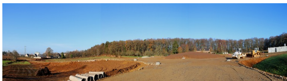
Les premiers terrassements à hauteur de la Vigne.
